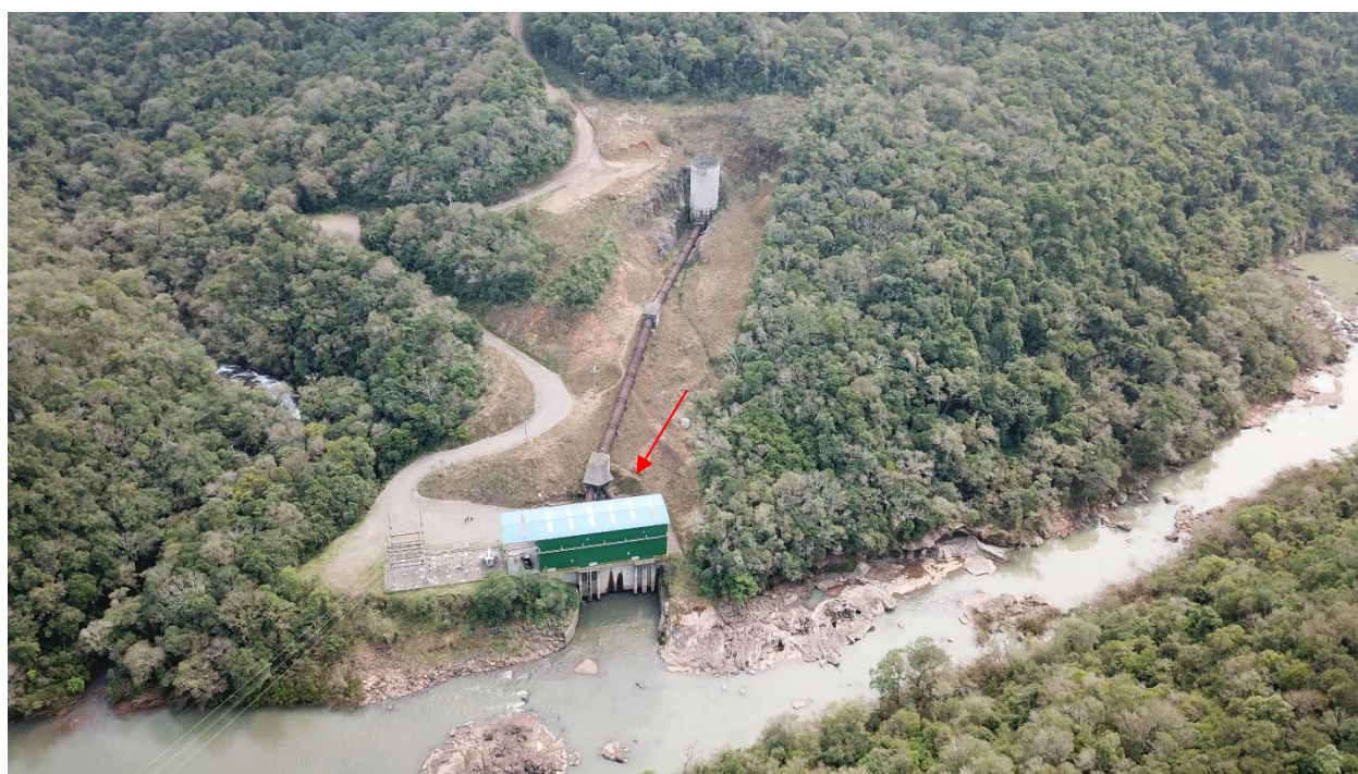
Figura 31 – Casa de Força da PCH Rastro de Auto
