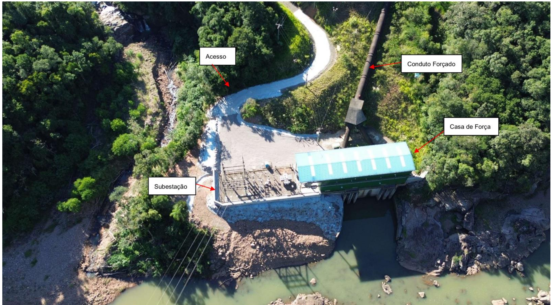
Figura 2 – Jusante da PCH Rastro de Auto (Casa de Força)
