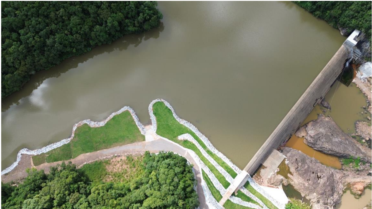
Figura 11 – Barragem da PCH Rastro de Auto (Vista Geral)
