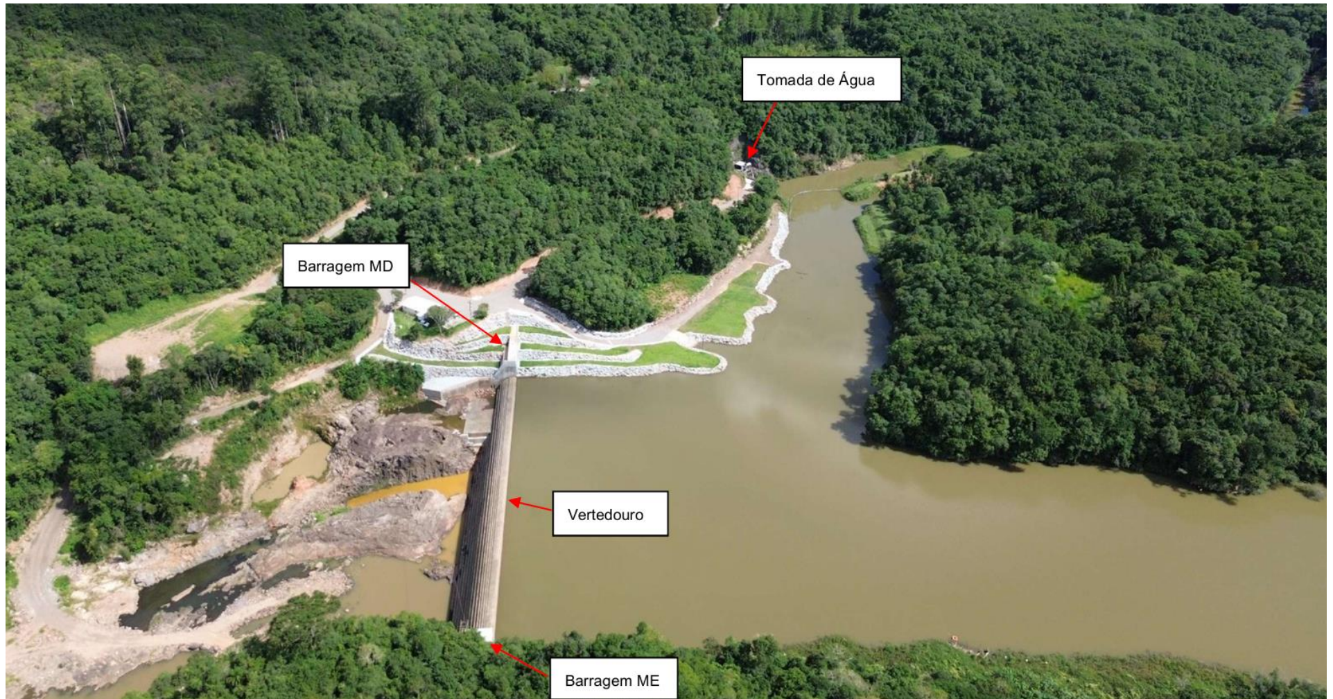
Figura 1 – Estruturas do Barramento da PCH Rastro de Auto
