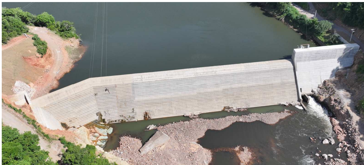
Figura 9 – Vertedouro da PCH Salto Forqueta
