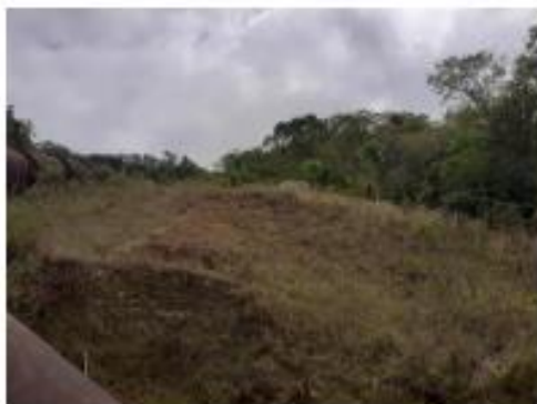
FIGURA 1. Talude junto à casa de máquinas.
