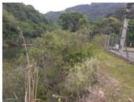
FIGURA 3. Talude junto à subestação, paralelo ao Rio Forqueta.
