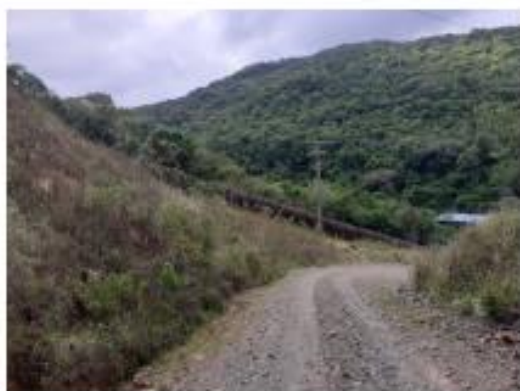
FIGURA 2. Talude lateral e acesso para a casa de máquinas.
