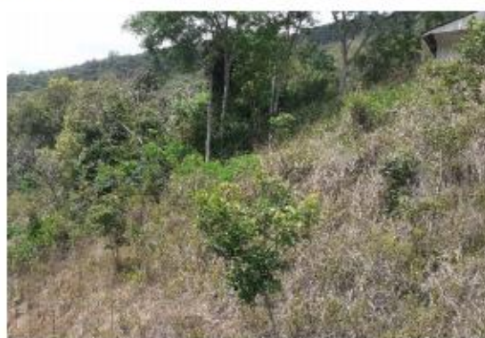
FIGURA 4. Talude a jusante do barramento.
