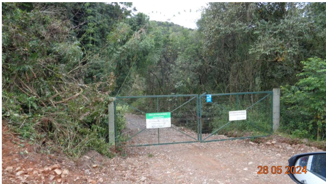
Figura 40 – Portão de acesso a casa de força em bom estado
