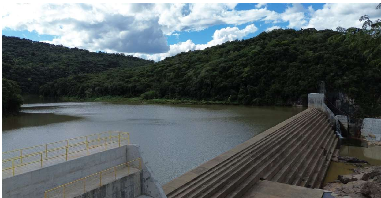
Figura 10 – Vertedouro da PCH Rastro de Auto
