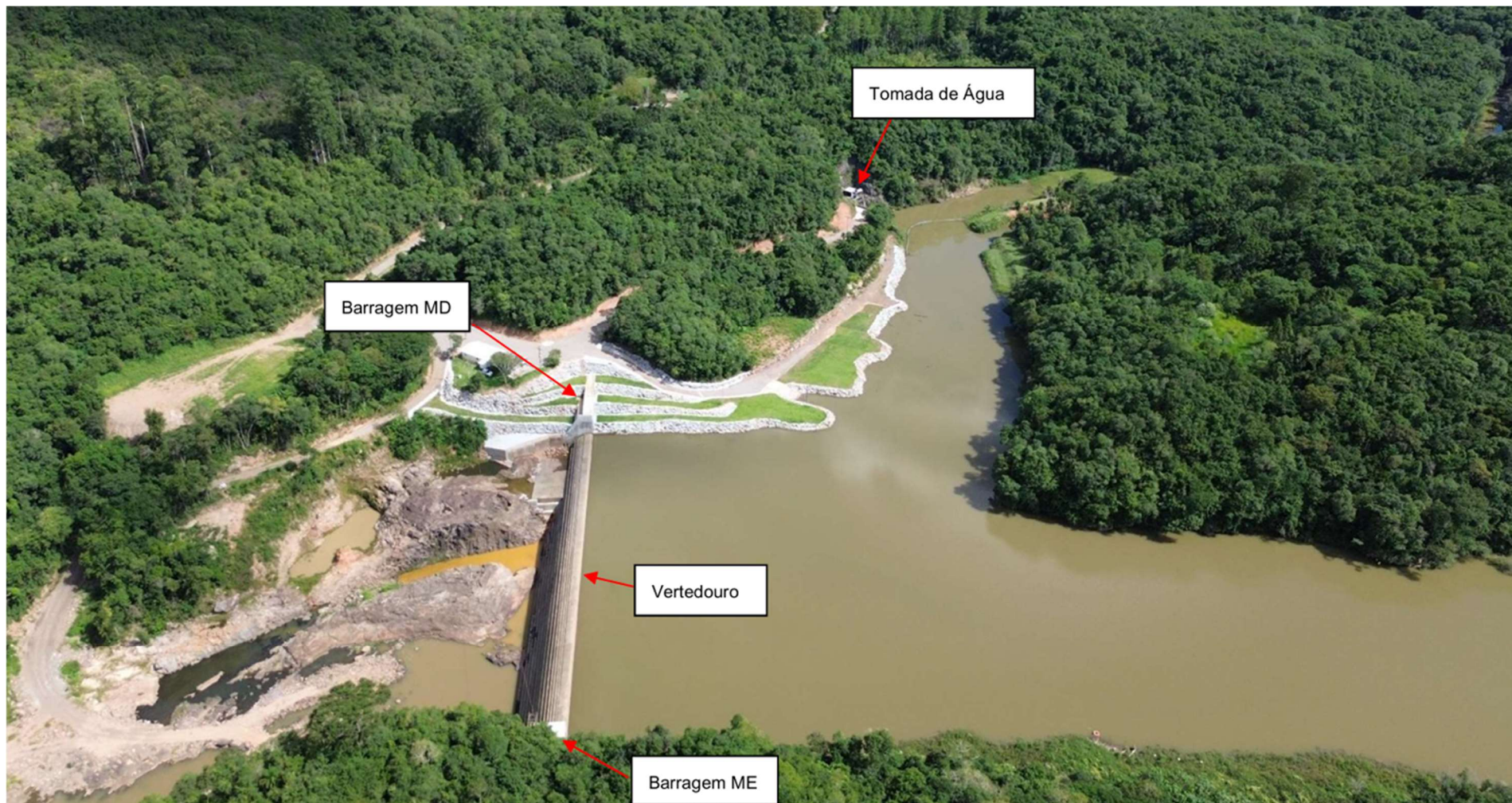
Figura 2 – Estruturas do Barramento da PCH Rastro de Auto
