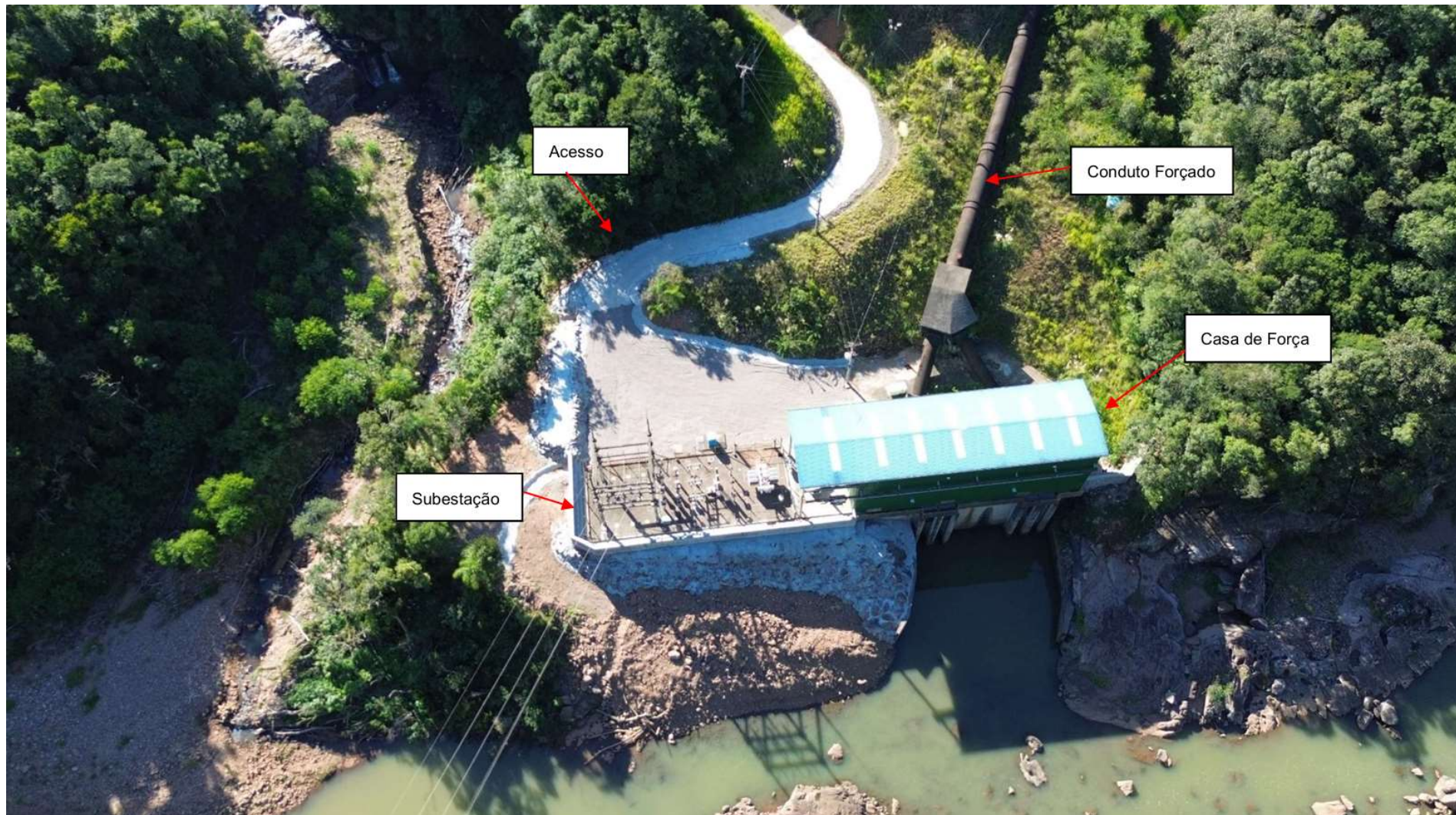
Figura 3 – Jusante da PCH Rastro de Auto
