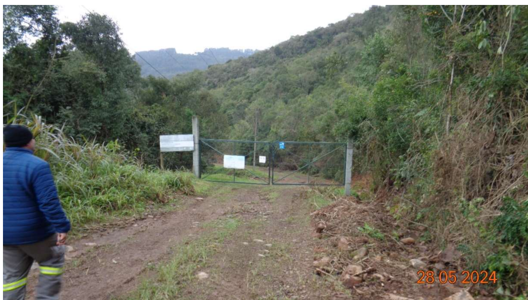
Figura 41 – Acesso para a barragem com cerca e portão
