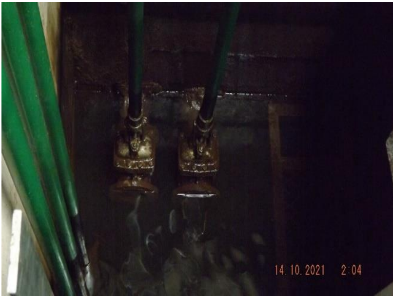
Foto 4: Poço de drenagem da PCH Cazuza Ferreira.
