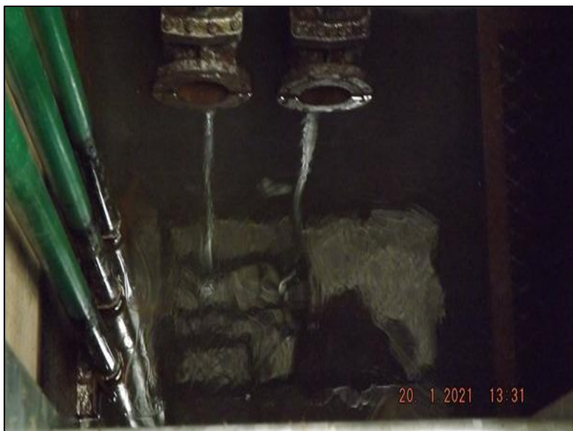
Foto 14: Caixa de drenagem da PCH Cazuza Ferreira.
