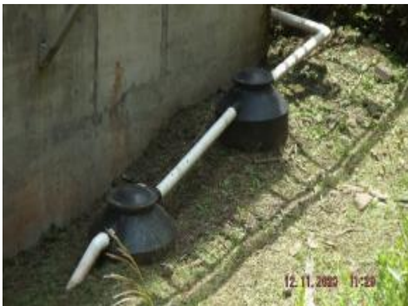
Foto 3: Fossas sépticas instaladas na casa de força.
