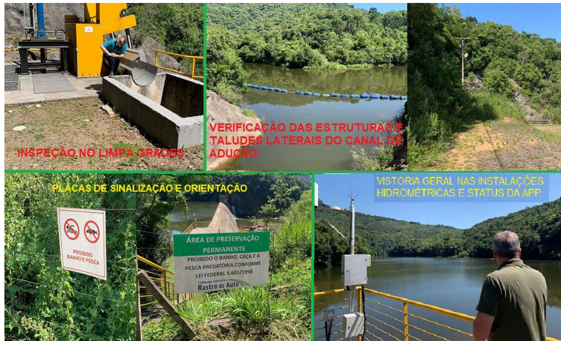
FIGURA 1. Imagens da vistoria realizada em 17 de fevereiro de 2022.
