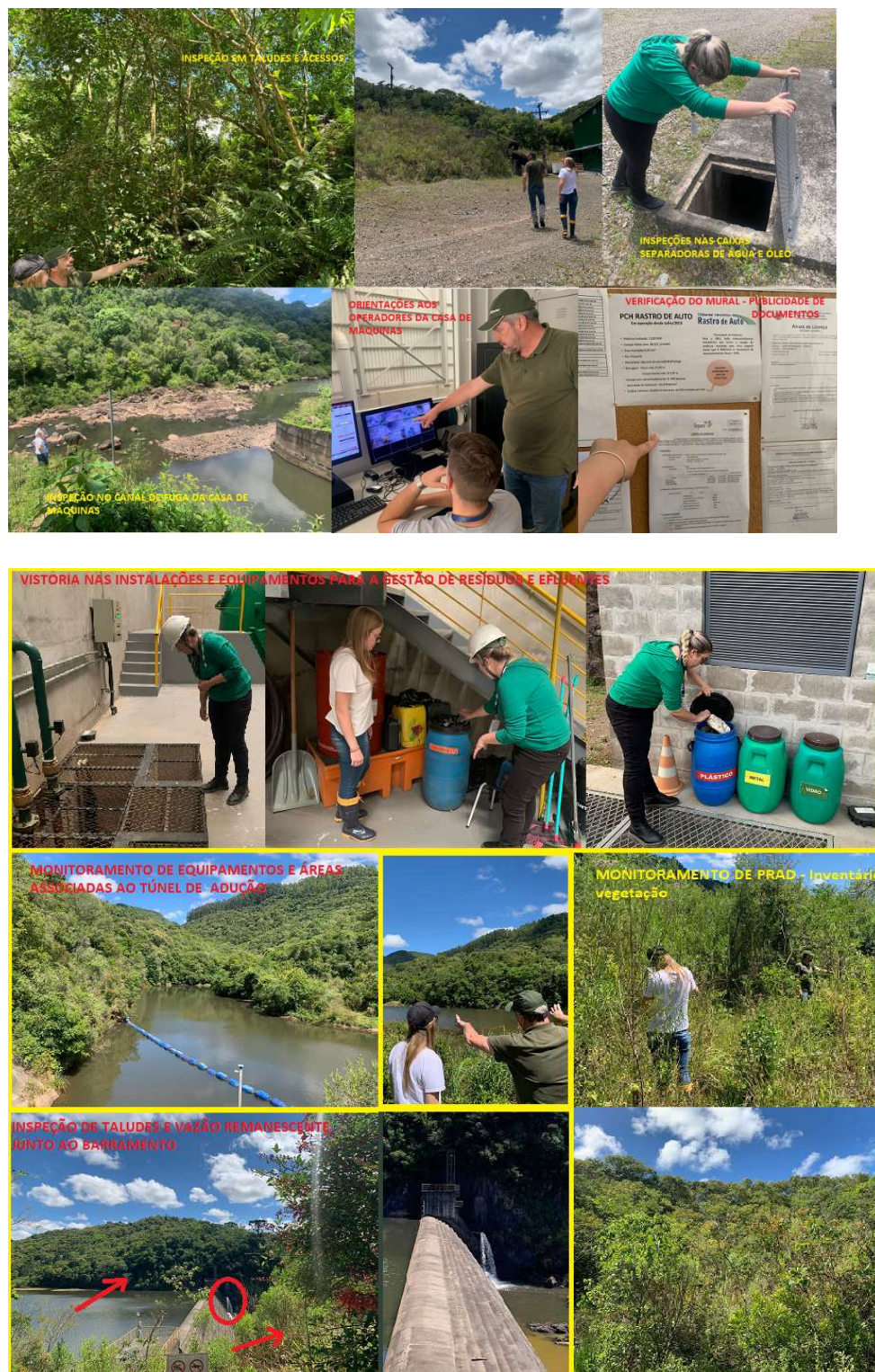
Figura 4. Imagens da vistoria realizada em 09 de novembro de 2022.
