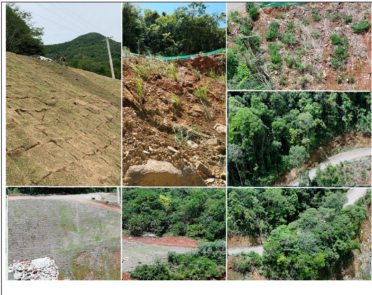
FIGURA 09. Taludes situados junto às ombreiras foram cobertos por leivas e plantio de gramíneas nativas.
