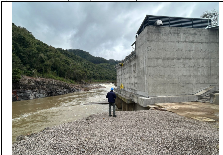
FIGURA 03: Aspecto da casa de máquinas após a reconstrução.
