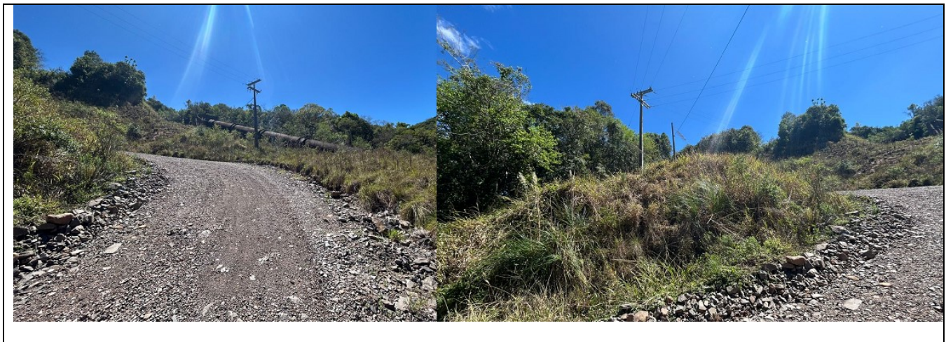
Figura 6. Imagens de vistorias realizadas em período de desassoreamento - julho a novembro de 2025 – acessos e taludes em ótimo estado junto á casa de máquinas.
