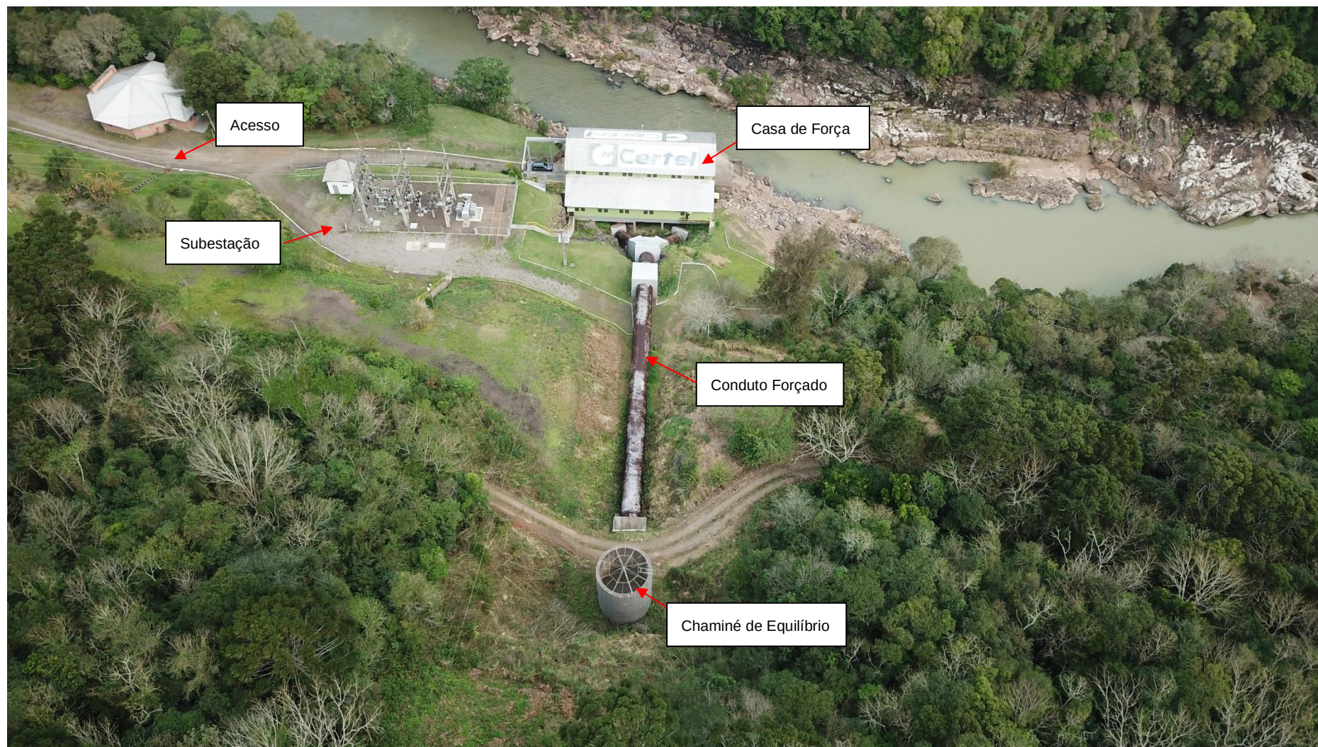
Figura 2 – Região da casa de força da PCH Salto Forqueta
