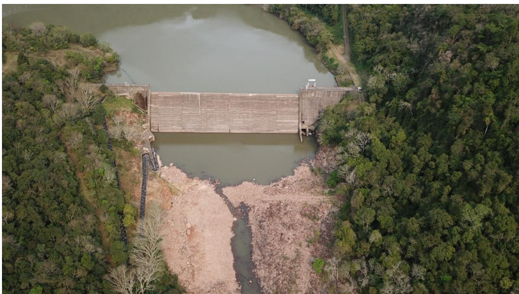
Figura 19 – Vista Geral do Barramento
