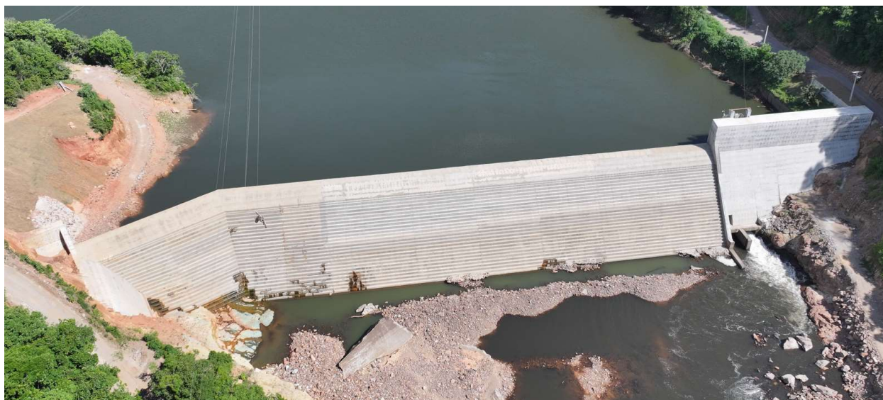
Figura 12 – Vertedouro da PCH Salto Forqueta
