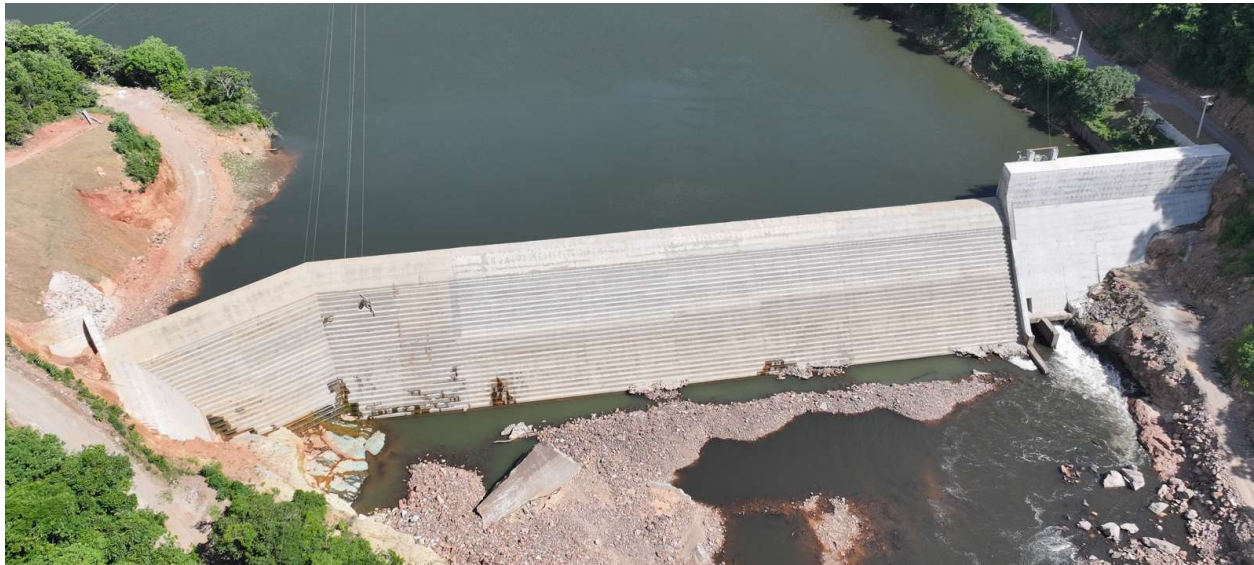
Figura 12 – Vertedouro da PCH Salto Forqueta
