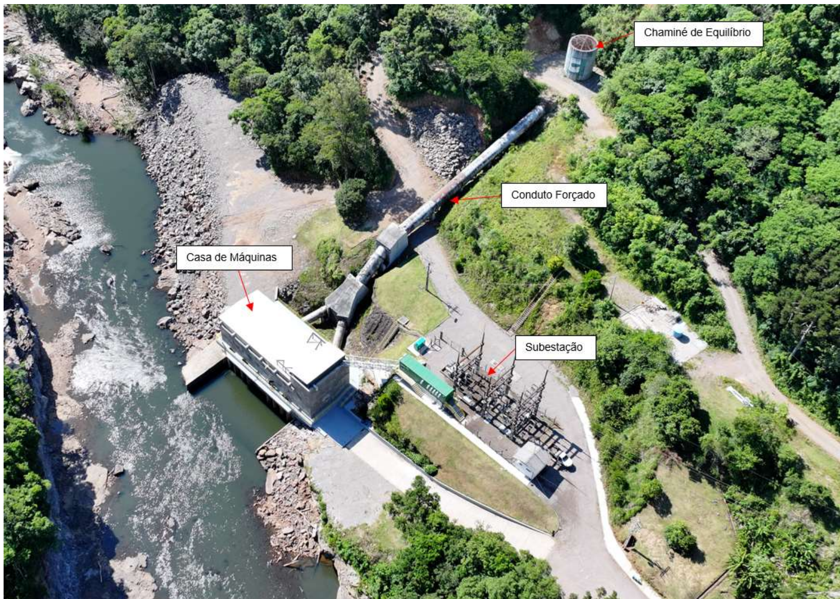
Figura 9 – Casa de máquinas recuperada em 2025 da PCH Salto Forqueta
