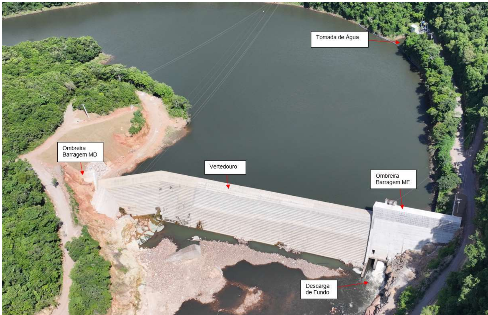
Figura 8 – Estruturas do Barramento Recuperada em 2025 da PCH Salto Forqueta
