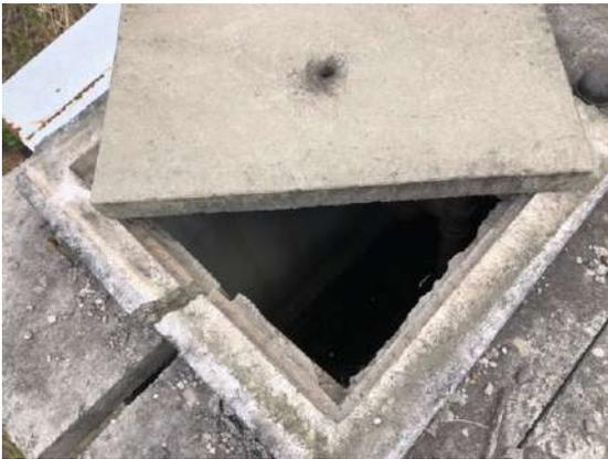
Figura 28 – Caixa do tanque da subestação
