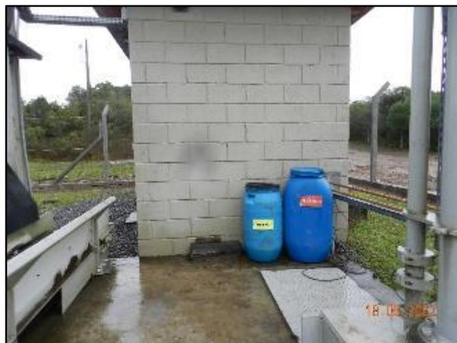
**Figura 8 – Recipientes utilizados para acondicionamento dos resíduos resultantes do limpagrades.**
