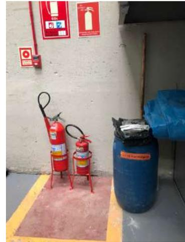
Figura 33 – Extintores, alarme e kit de emergência ambiental na casa de máquinas
