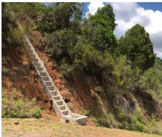
Figura 12 – Escadas para controle de erosão
