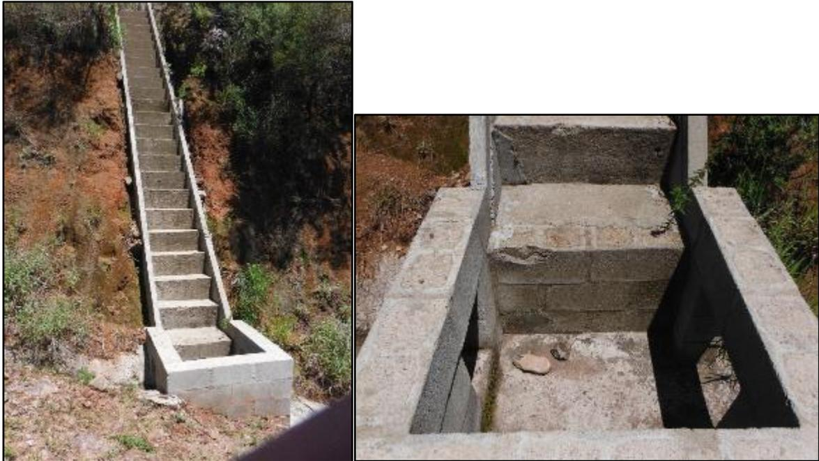
**Figura 4 - Escadaria e caixa de dissipação de energia d'água.**
