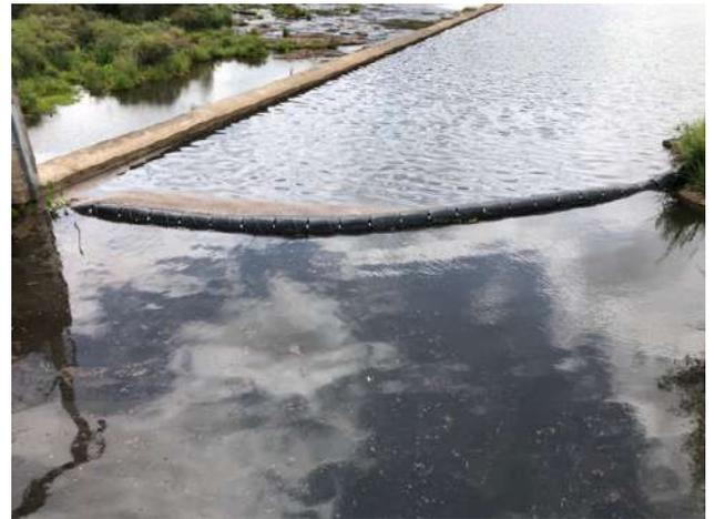
Figura 21 – Tomada de água e log boom
