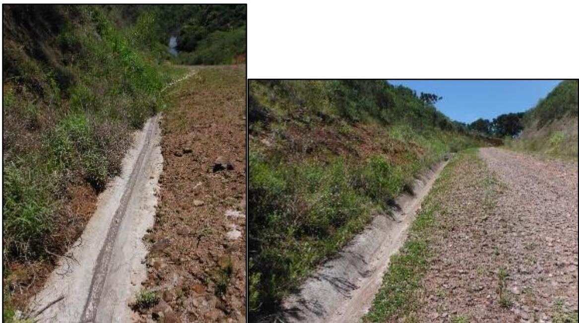
**Figura 5 - Sistema de drenagem instalado ao longo do empreendimento, em excelente condições de manutenção.**
