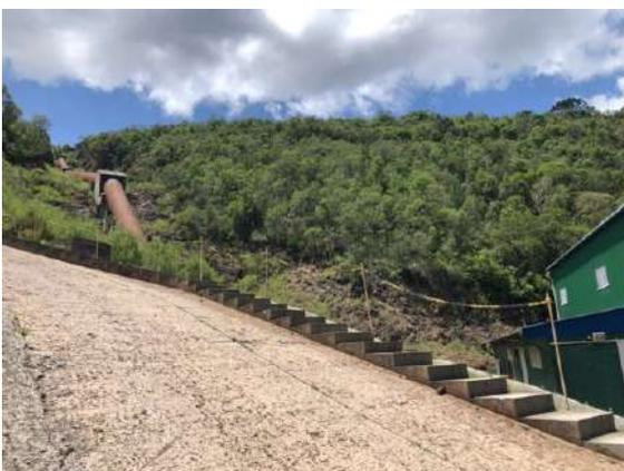
Figura 30 – Duto forçado descendo até a casa de máquinas
