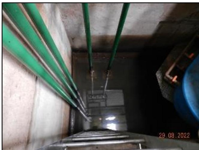
**Figura 6 – Caixa Separadora de Água e Óleo (CSOL).**
