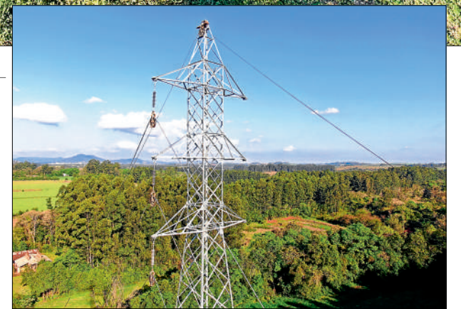
26 torres metálicas foram instaladas
