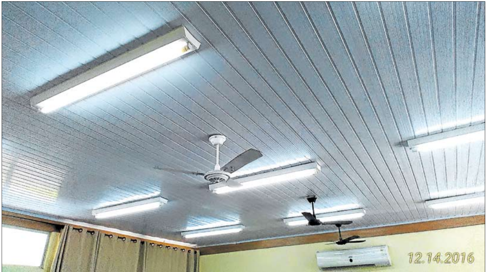
Substituição de lâmpadas na Escola Gomes Freire de Andrade, de Teutônia
