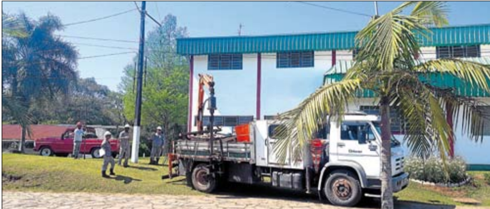
Foram substituídos cabos de baixa tensão e estrutura na rede de média tensão
