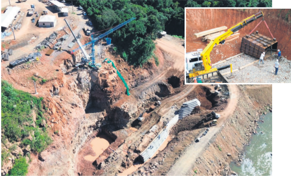
Concretagem já iniciou e também chegaram as peças das turbinas
