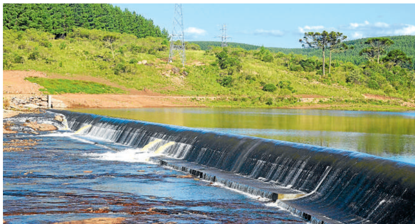
Hidrelétrica Cazuza Ferreira
