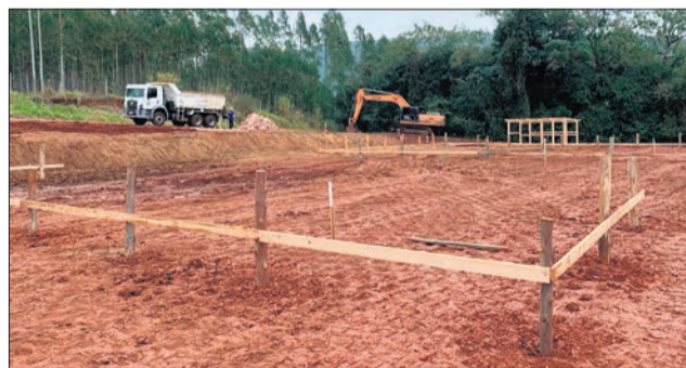
Obras em andamento
