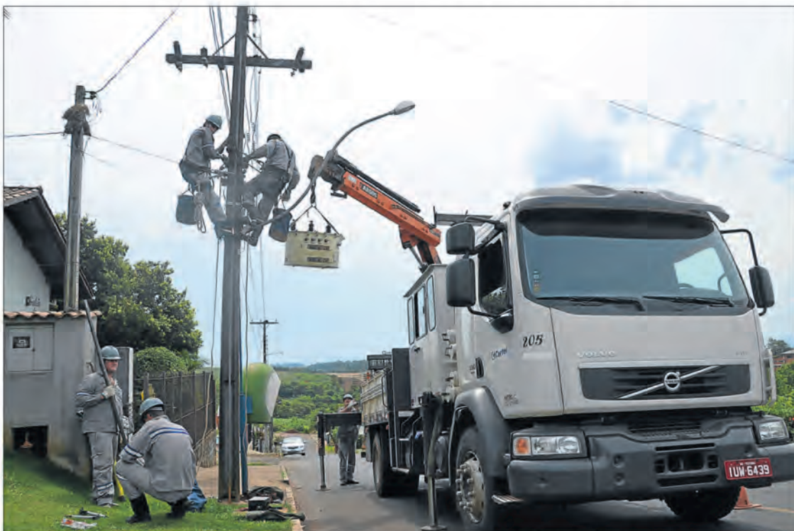
Profissionais da Certel Energia substituindo transformador no Bairro Canabarro, em Teutônia
