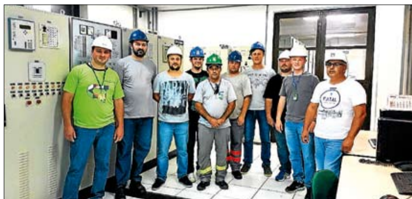
Central de comando da Hidrelétrica Salto Forqueta
