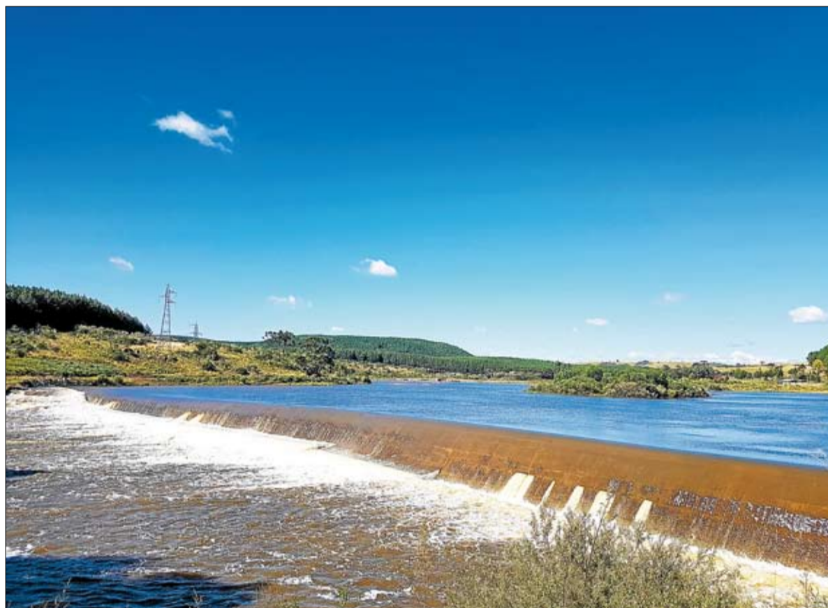
Barragem da Hidrelétrica Cazuza Ferreira, em São Francisco de Paula
