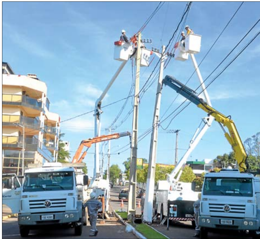
Recente colisão em poste mobilizou profissionais da Certel Energia
