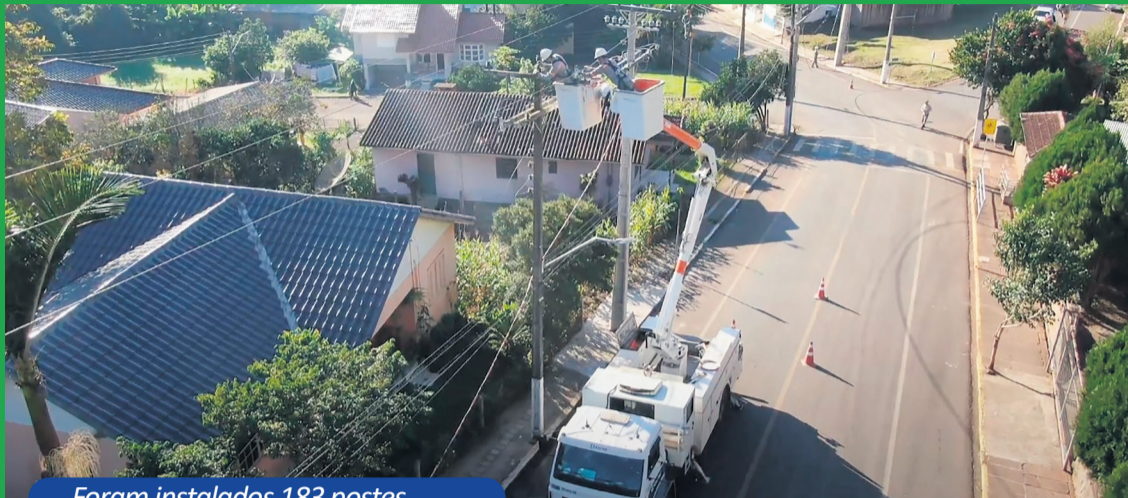
Foram instalados 183 postes
