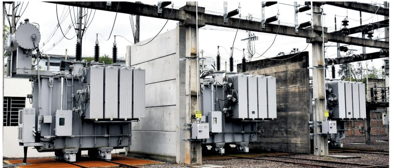
O local passou a contar com três transformadores e 11 alimentadores
