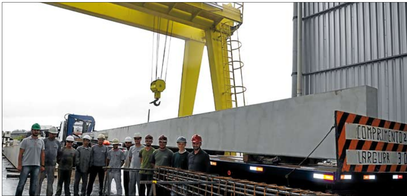
Parte dos profissionais da indústria com a primeira estrutura de 20 metros e 15 toneladas destinada à subestação
