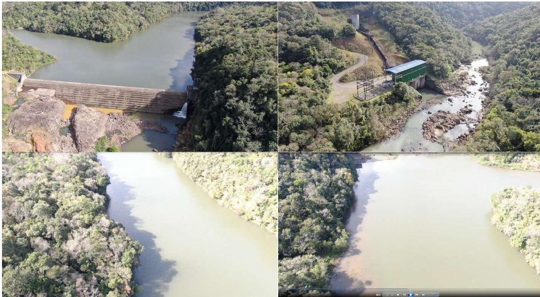
Figura 12. A utilização de drone auxilia na vistoria, na verificação de não conformidades e, em especial, na fiscalização da APP e áreas diretamente associadas ao empreendimento.
