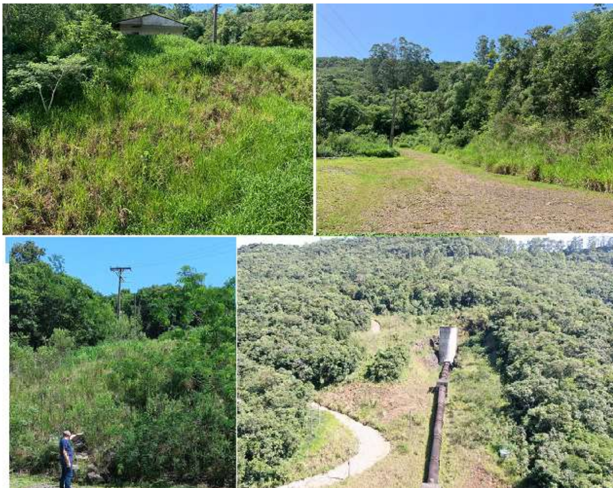
Figura 11. Em 2023, vistorias realizadas identificaram a plena cobertura do solo com vegetação nativa nos taludes e o bom estado dos acessos.
