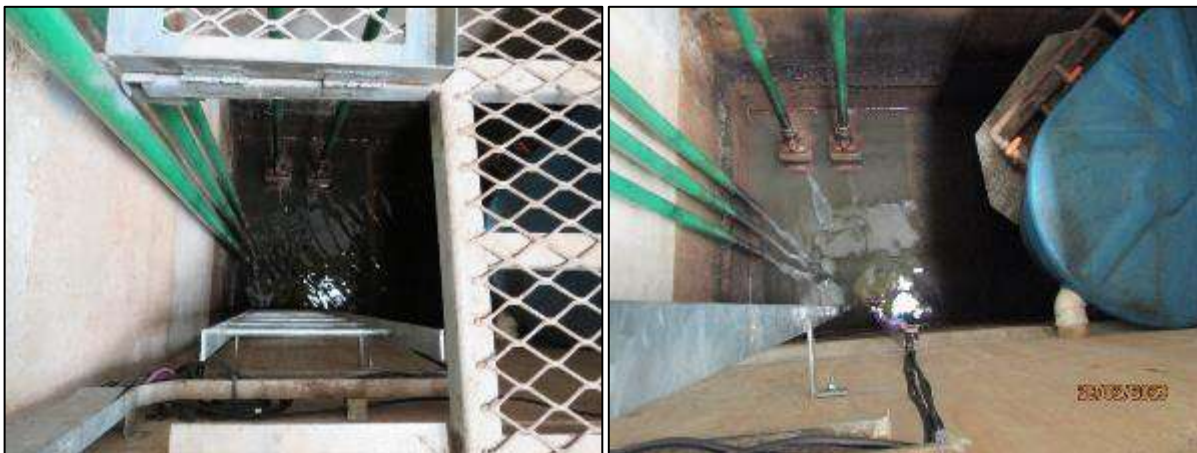
Figura 5 – Poço de drenagem sem necessidade manutenção.
