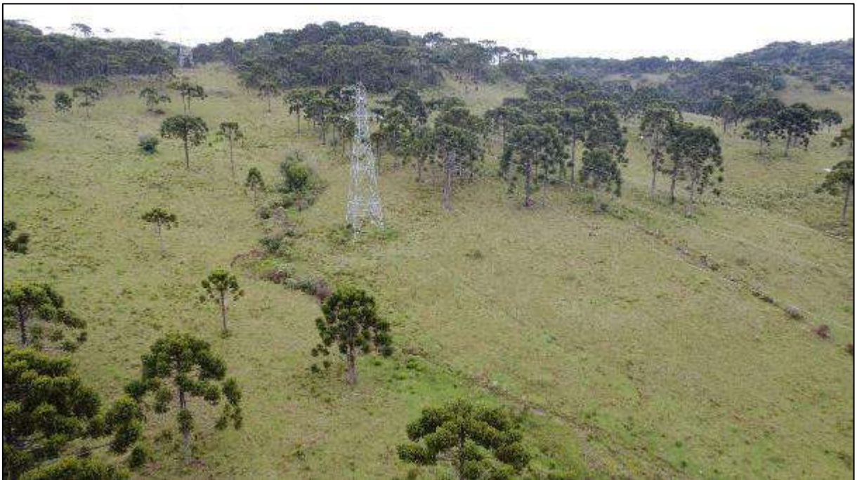
Imagem aérea 7 - Torre 24 está próxima a um curso d'água e não apresenta sinais de instabilidade.
