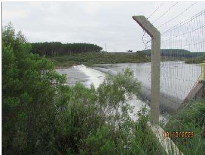
Figura 24 - Vista geral do barramento.
