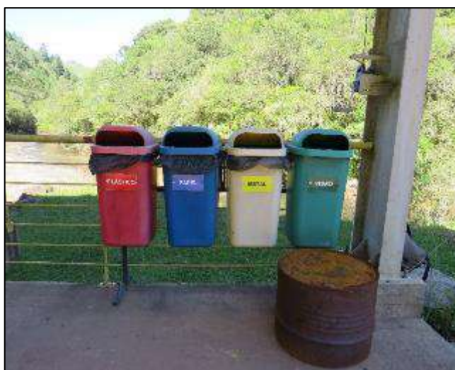
Figura 97 - Conjunto de lixeiras para separação de resíduos, localizadas na entrada da casa de força.
