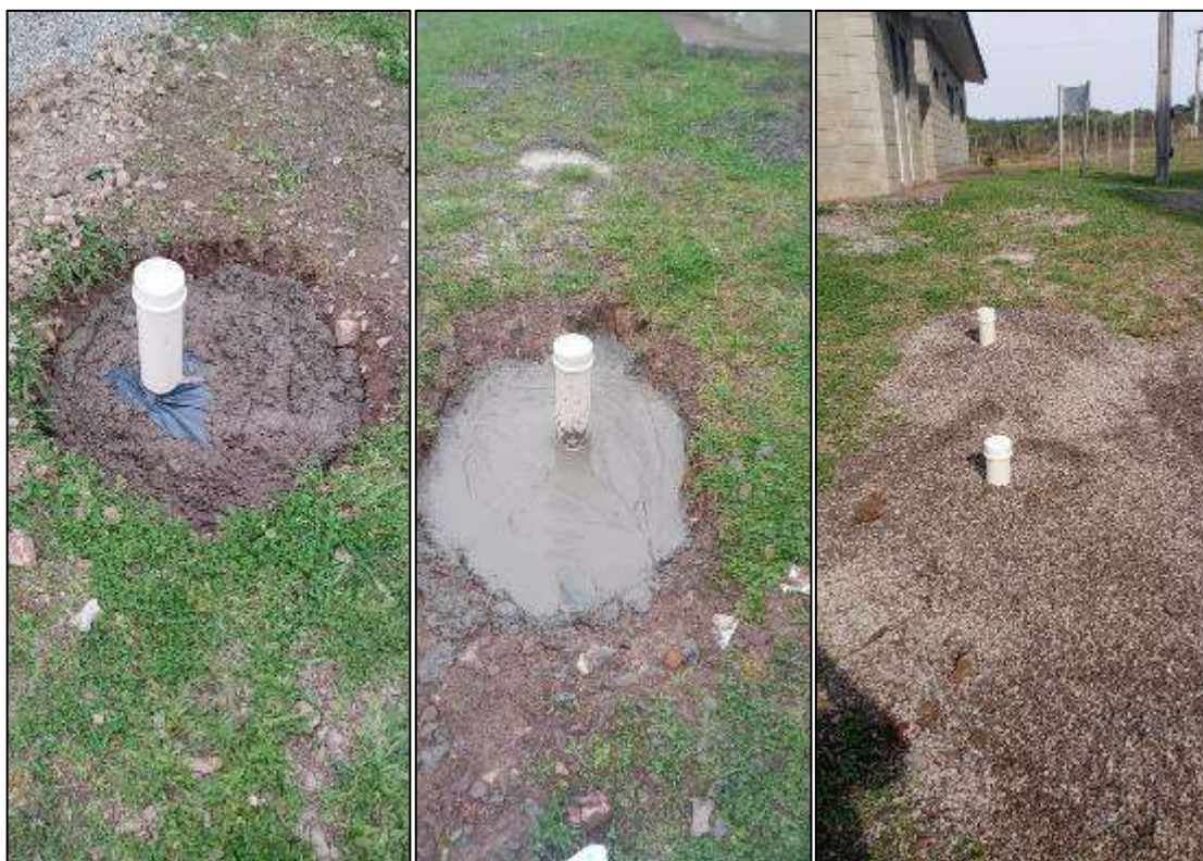
Figura 4 – Manutenção e reestruturação do sistema fossa e filtro do CEA.
