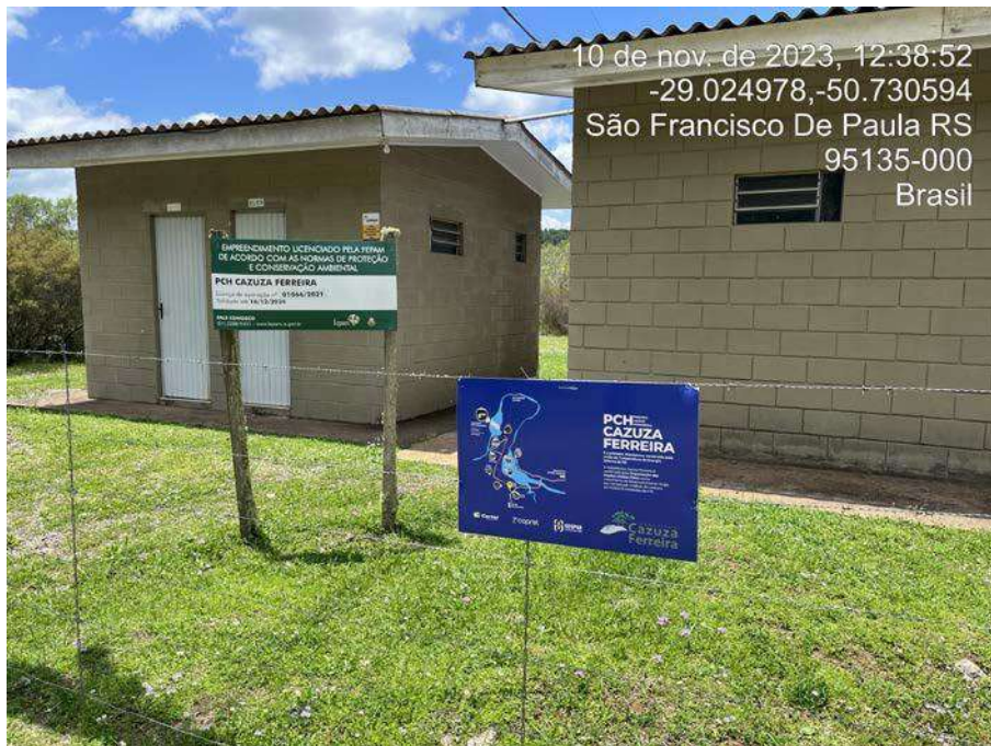
Figura 3 – Visão geral da entrada e da placa de identificação
