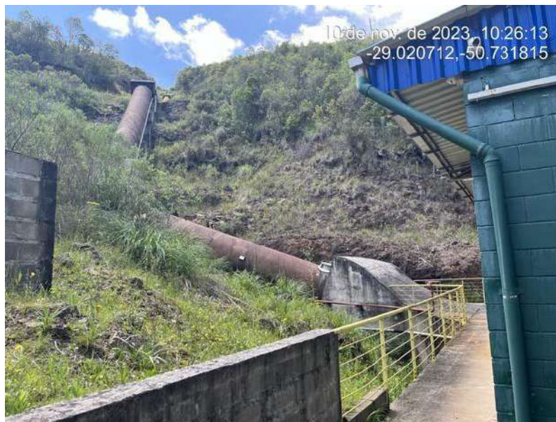
Figura 7 – Visão geral do conduito forçado
