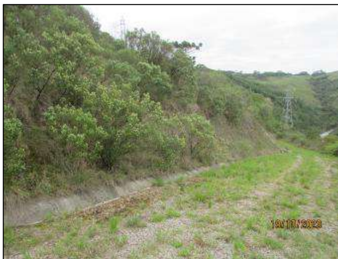
Figura 12 - Acesso à tubulação com talude parcialmente coberto por vegetação e canaleta de escoamento de água pluvial em sua base.
