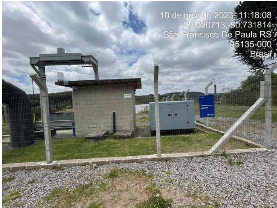
Figura 31 – Visão geral da área da “tomada d’água”
