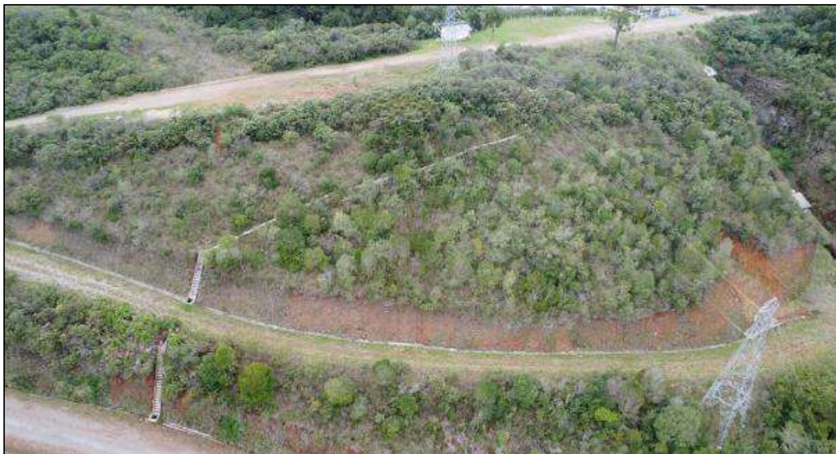
Imagem aérea 2 - Vista da canaleta de escoamento de água entre a mata e das escadarias de dissipação de energia de água pluvial.
