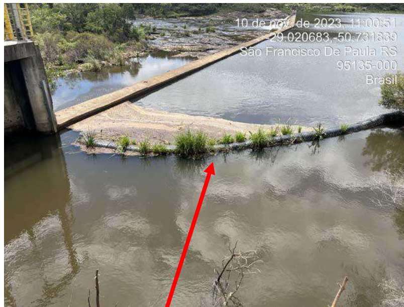
Figura 24 – Destaque para a barreira de contenção de resíduos, na barragem
