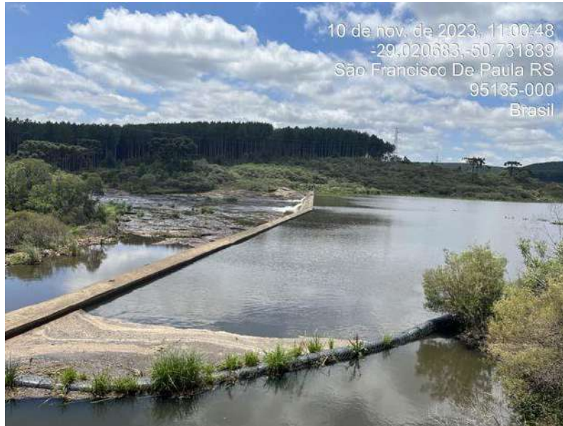
Figura 23 – Visão geral da barragem
