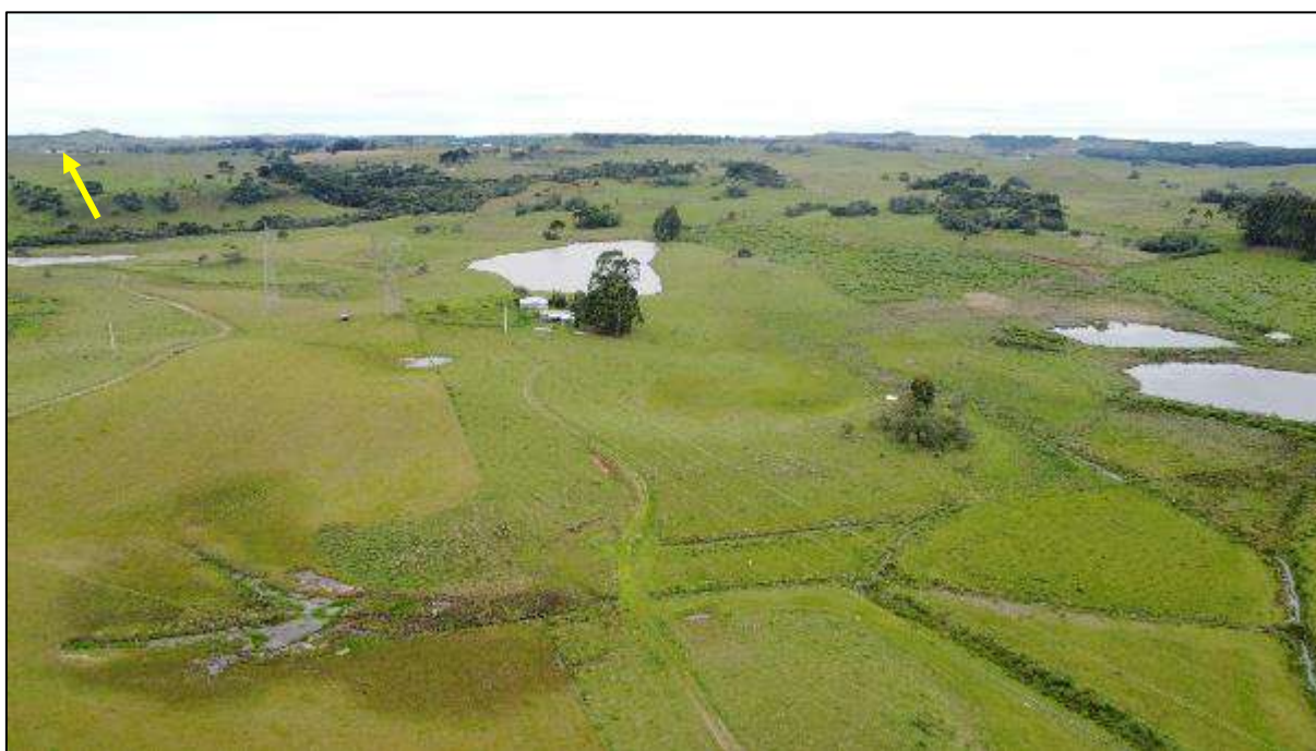
Imagem aérea 9 - Vista desde a torre 52 em direção a subestação que está indicada pela seta na foto.
