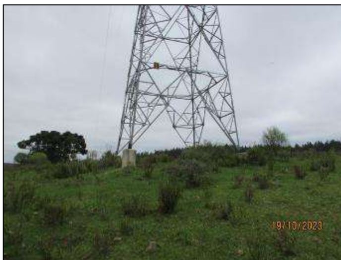
Figura 25 - Torre nº 8 em local com declividade suave.
