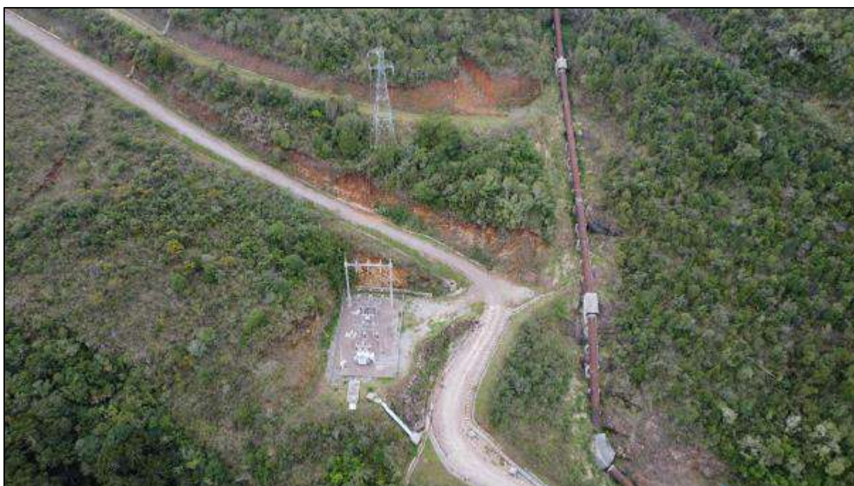
Imagem aérea 1 - Vista do conduto forçado, subestação e acessos as áreas da usina.
