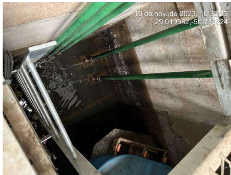
Figura 12 – Poço de drenagem – visão geral do interior
