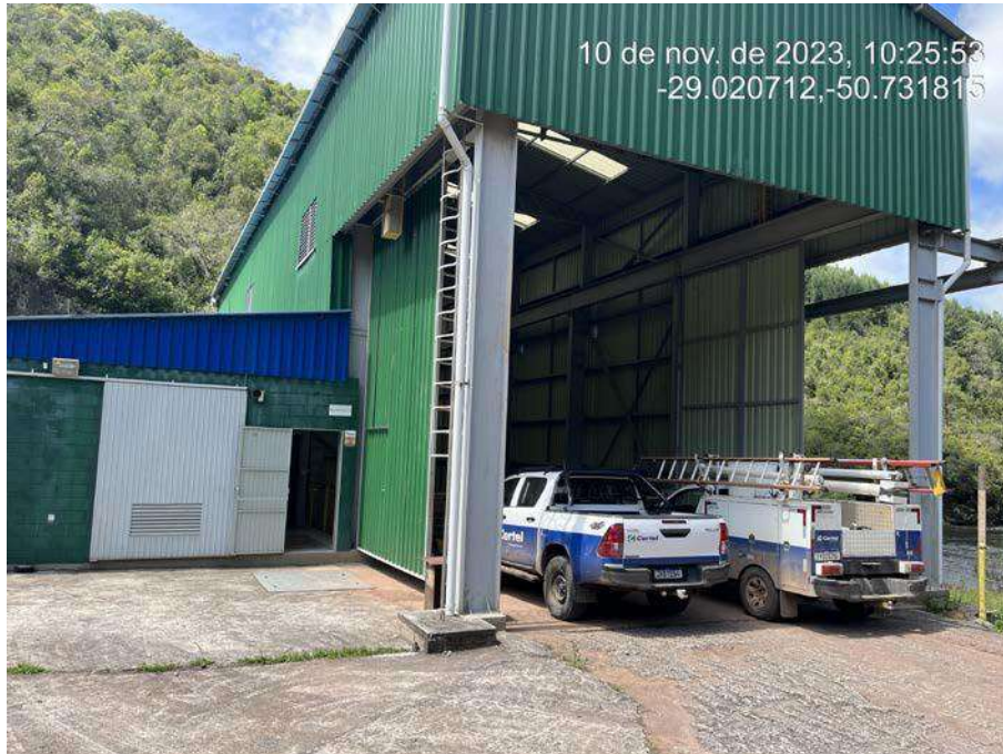
Figura 6 – Visão geral da casa de força
