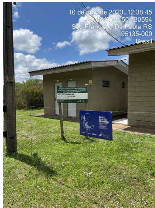
Figura 4 – Visão geral da entrada e da placa de identificação
