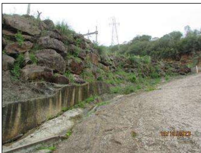
Figura 21 - Talude de enrocamento a Sul da subestação não apresenta movimentação aparente, mas esse deve ser constantemente monitorado.
