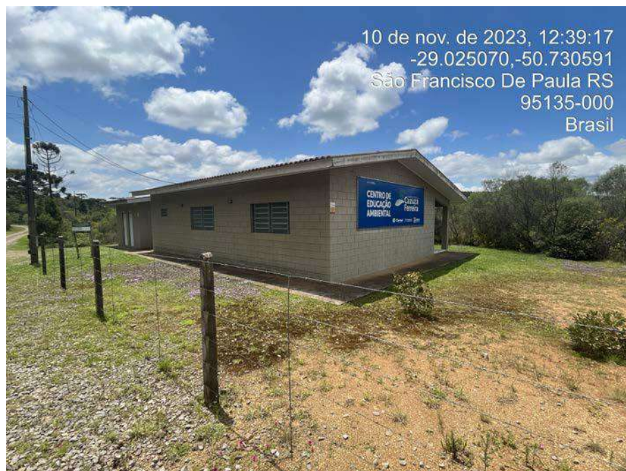
Figura 5 – Visão geral do prédio na entrada da PCH (Centro de Educação Ambiental)
