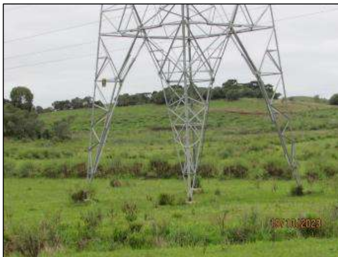
Figura 29 - Torre 52 em área plana sem indícios de problemas geotécnicos.
