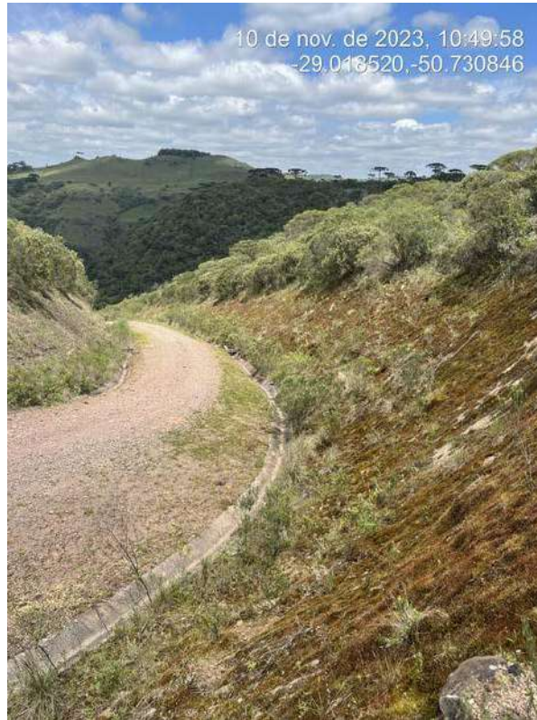
Figura 21 – Visão geral dos taludes e do acesso à casa de força
