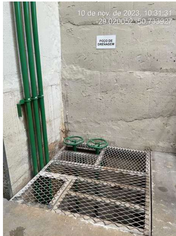
Figura 11 – Poço de drenagem – visão geral
