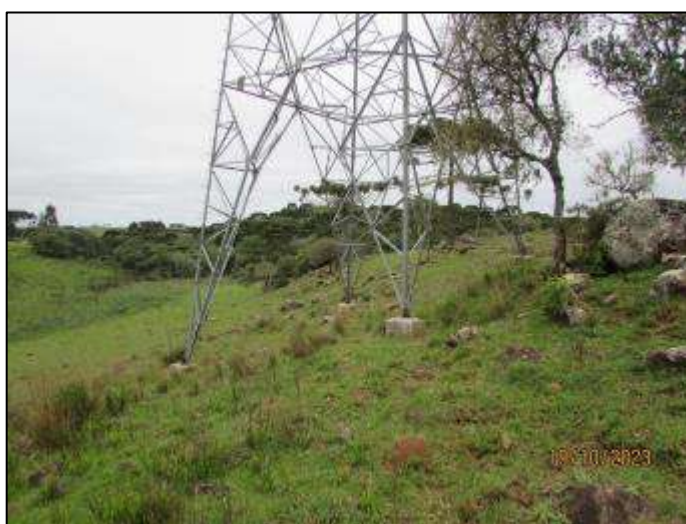
Figura 28 - Torre 37 está em área pouco mais íngreme que as outras estruturas, mas não apresenta sinais de instabilidade.
