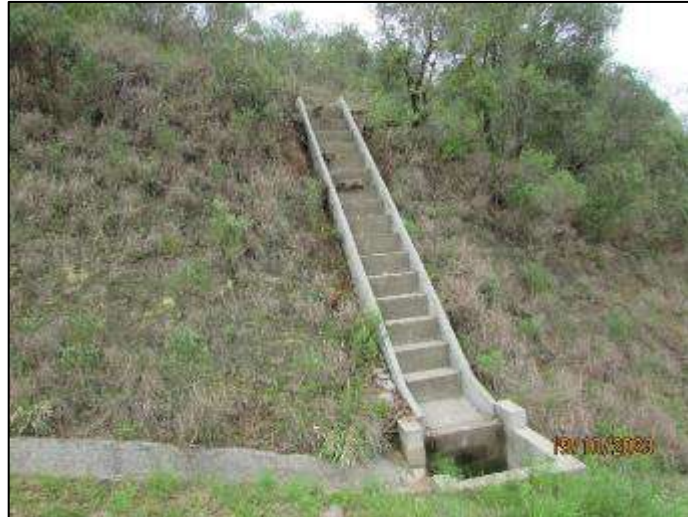
Figura 13 - Escadaria de dissipação de energia de água pluvial.
