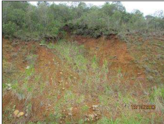
Figura 14 - Local onde houve uma movimentação de massa aparentemente está sem pontos de instabilidade.
