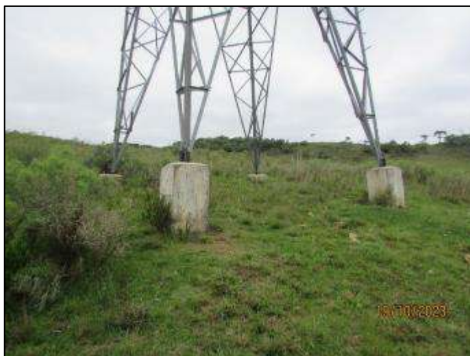
Figura 26 - Torre nº 15 próximo a uma antiga área de extração de saibro com suas bases em bom estado de conservação.
