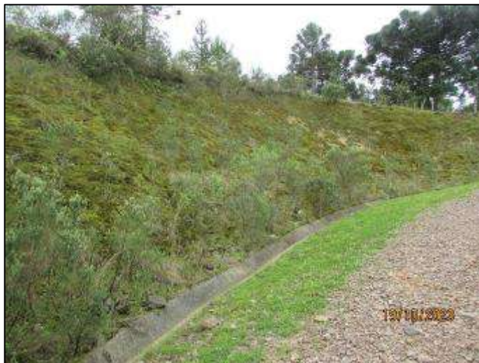
Figura 16 - Talude no lado direito do acesso à casa de força parcialmente vegetado e aparentemente estável.
