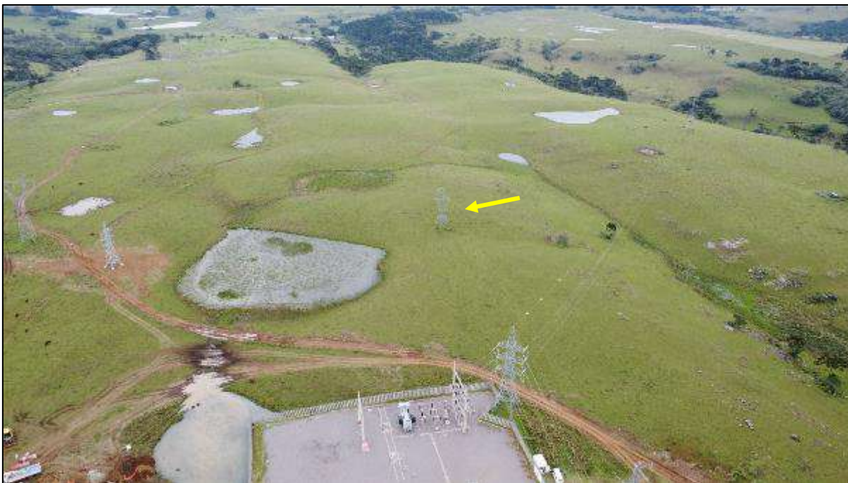
Imagem aérea 10 - Vista da subestação com a seta indicando a última torre antes da chegada da LT na subestação.
