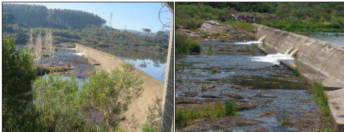
Figura 3 – Dispositivos de manutenção da vazão remanescente existentes no corpo da barragem, em pleno funcionamento, verificados durante o ano de 2023.
