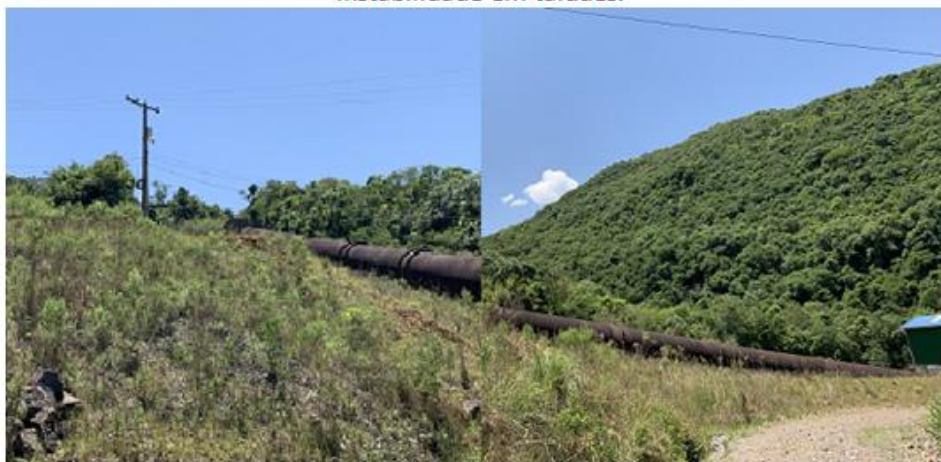
FIGURA 2. Junto à chaminé de equilíbrio e adutoras próximas à casa de máquinas, pela excelente cobertura vegetal, também não há indícios de processos erosivos ou instabilidade em taludes.
