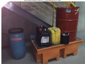
Figura 01: Recipientes contendo óleo sobre pallet de contenção ao lado de KIT DE EMERGÊNCIA AMBIENTAL
