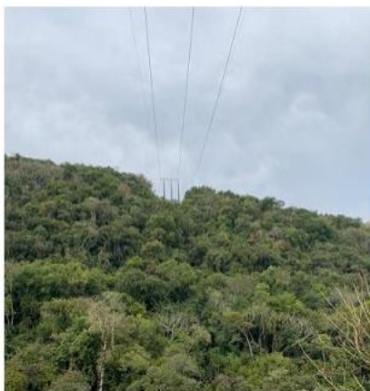
FIGURA 1. A instalação das torres em pontos mais altos do relevo na pequena extensão da Linha de Transmissão diminui a necessidade de manejo da vegetação.
