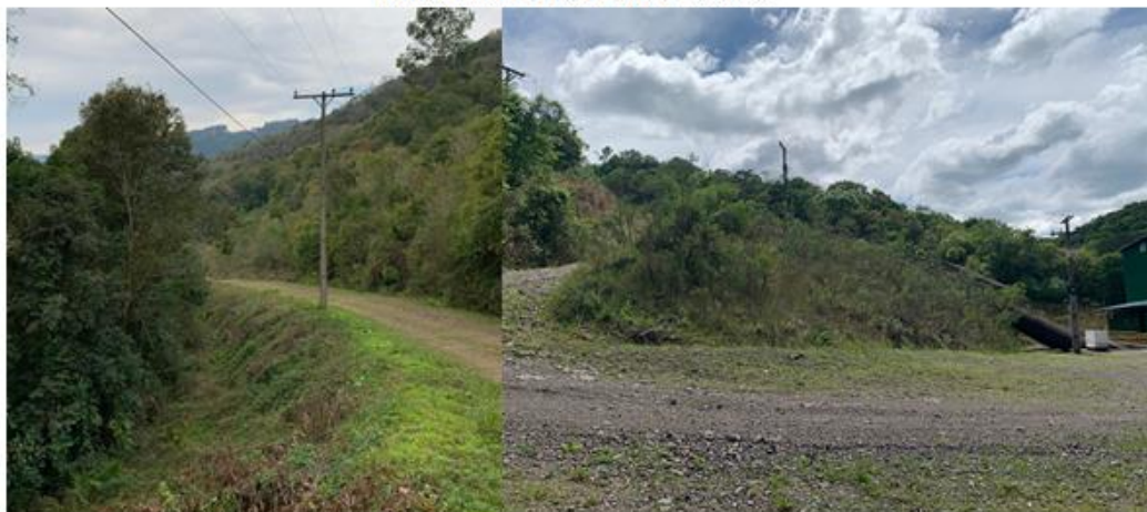
FIGURA 1. Nos acessos à casa de máquinas e nos taludes do entorno é perceptível o ambiente restaurado e estável.
