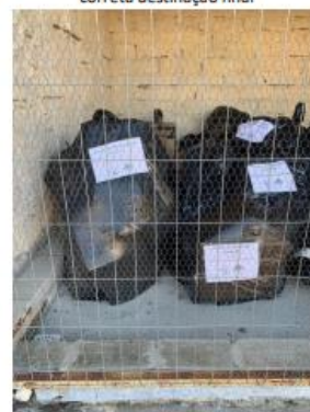
Figura 05: Resíduos Classe I armazenados na matriz da CERTEL até a consolidação de carga para correta destinação final
