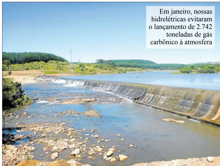
Barragem da Hidrelétrica Cazuzza Ferreira, em São Francisco de Paula
