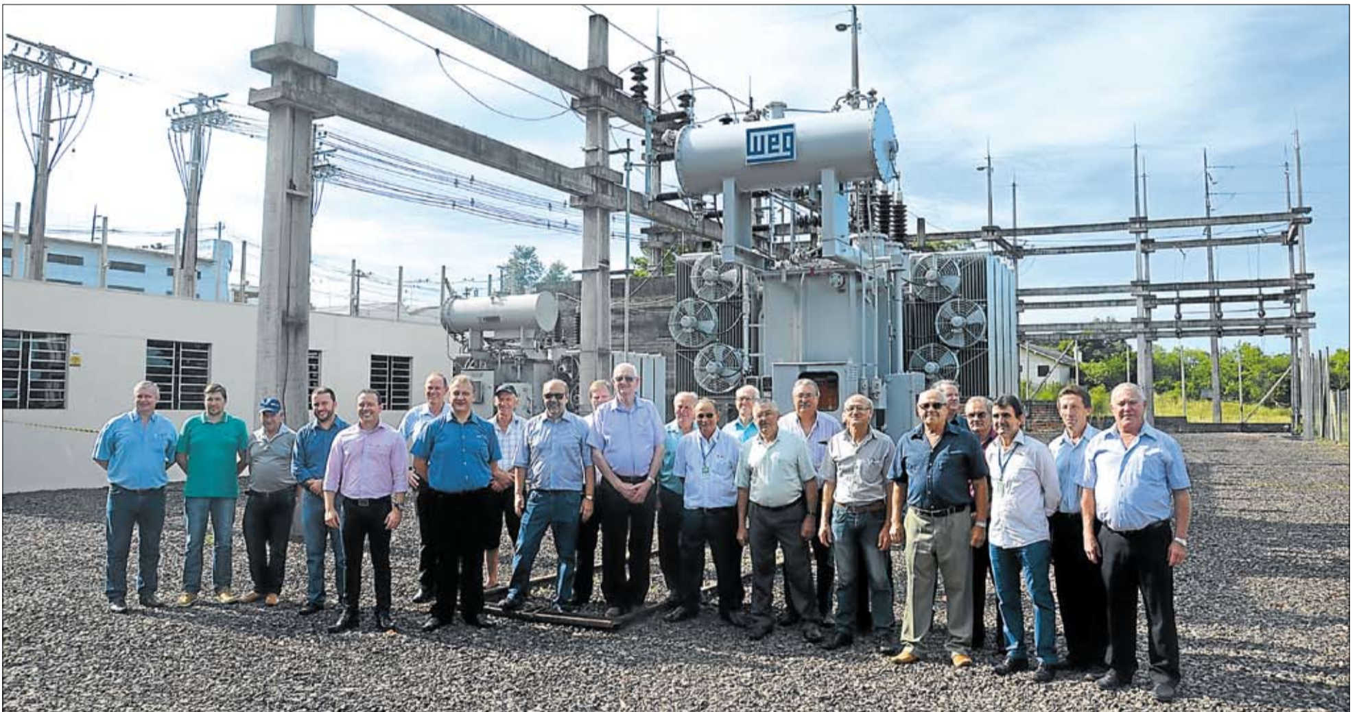
Novos transformadores em Teutônia (foto) e São Pedro da Serra garantem suprimento de energia para a próxima década. Páginas 6 e 7
