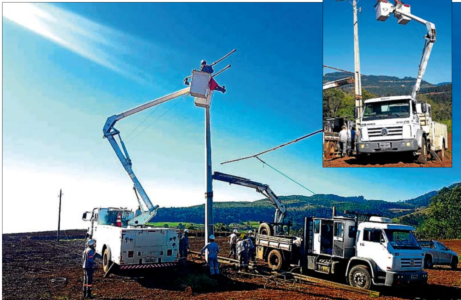
Manutenções preventivas com rede energizada, como a recentemente realizada em Barra do Fão, Pouso Novo, são fundamentais para a qualidade do fornecimento
