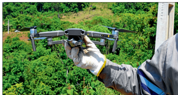
Lançamento de cabos via drone reduziu impacto ambiental
