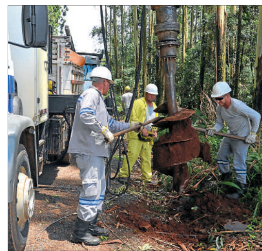
Ventania causou quedas de árvores, postes e danificou estruturas energéticas
