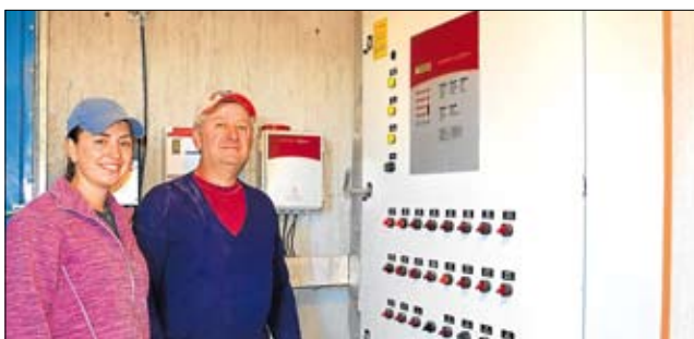
Pai e filha junto ao painel de comando do aviário
