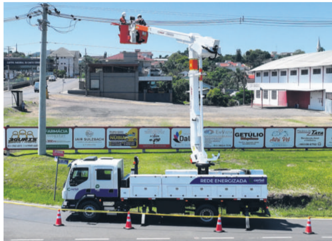
Atividade é realizada sem que o associado perceba alguma oscilação na rede elétrica
