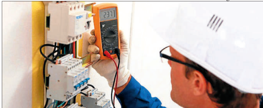
Fique atento em sua instalação elétrica
