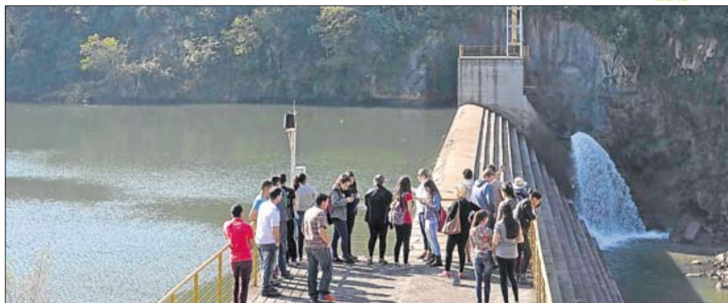
Visita à barragem da PCH, no leito do rio Forqueta, mostrou harmonia ambiental
