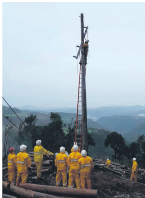
Linha Orlando, Marques de Souza
