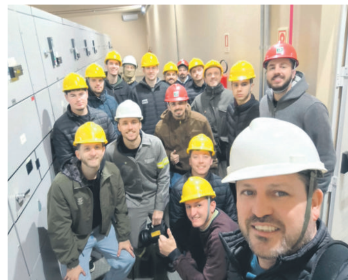
Alunos da Univates conheceram de perto uma subestação de 69 kV
