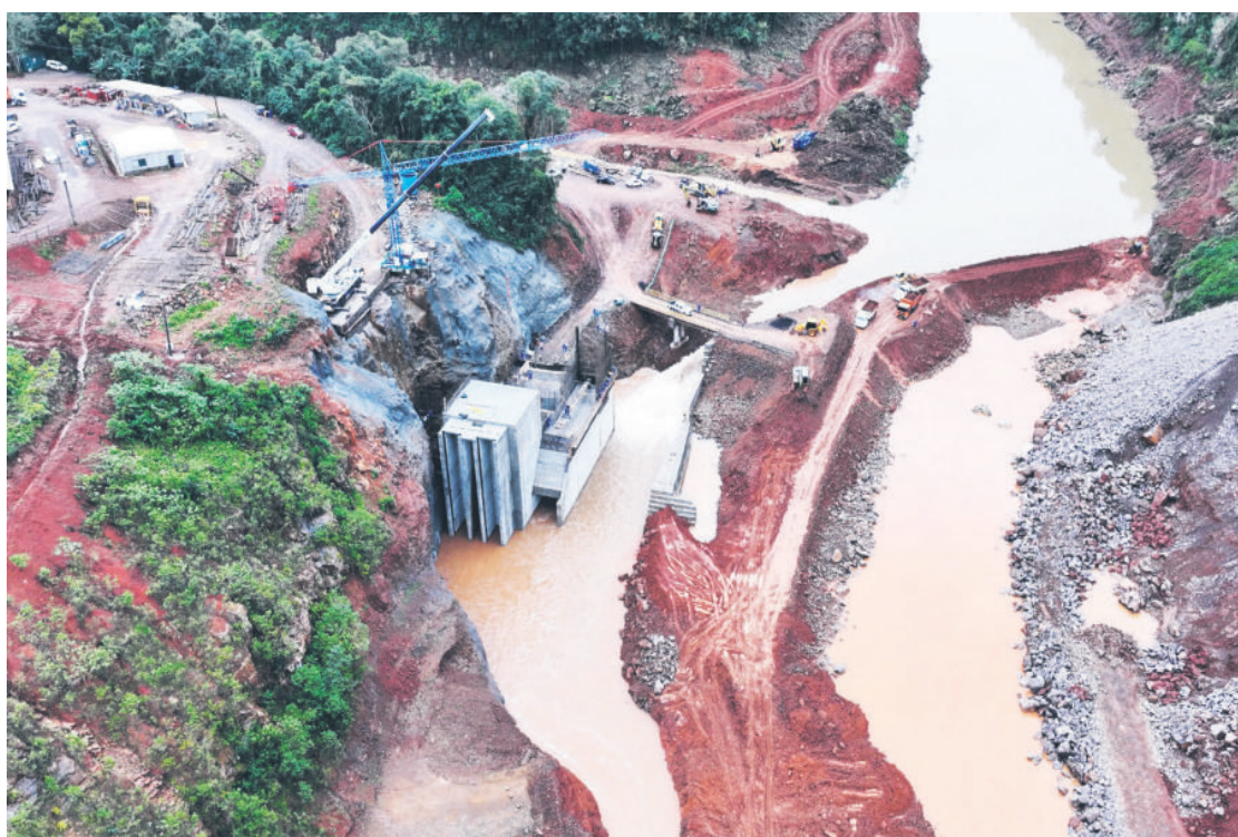
O curso do rio é modificado temporariamente para possibilitar a construção da barragem de forma adequada e segura
