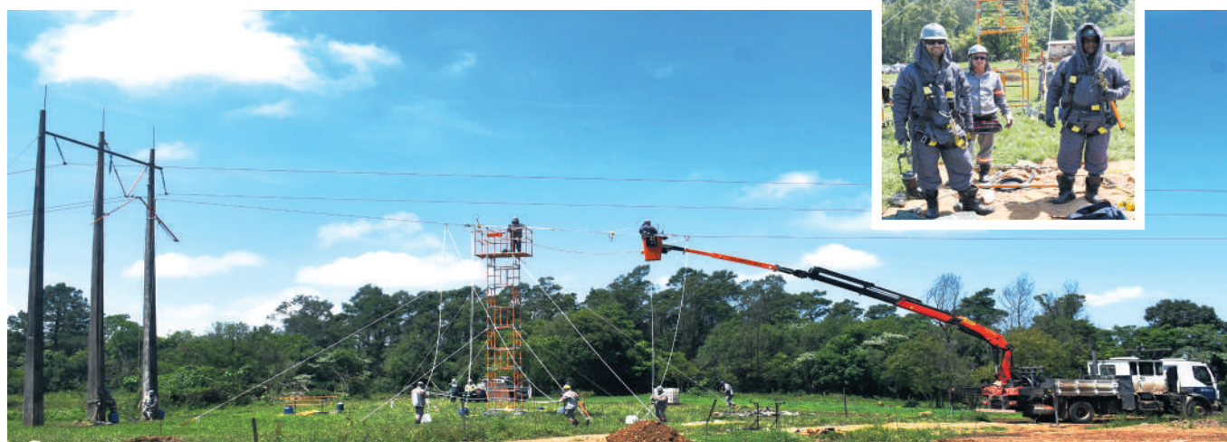
Três equipes realizaram a atividade, sendo uma no andaime, uma no cesto do caminhão e outra no poste
