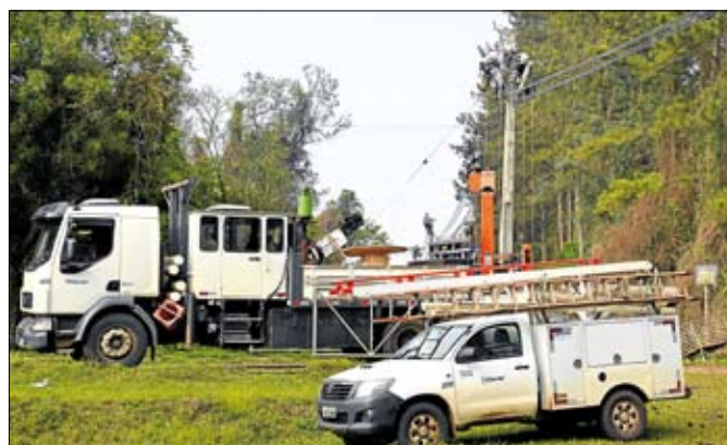
Obras junto à Associação da Elegê
