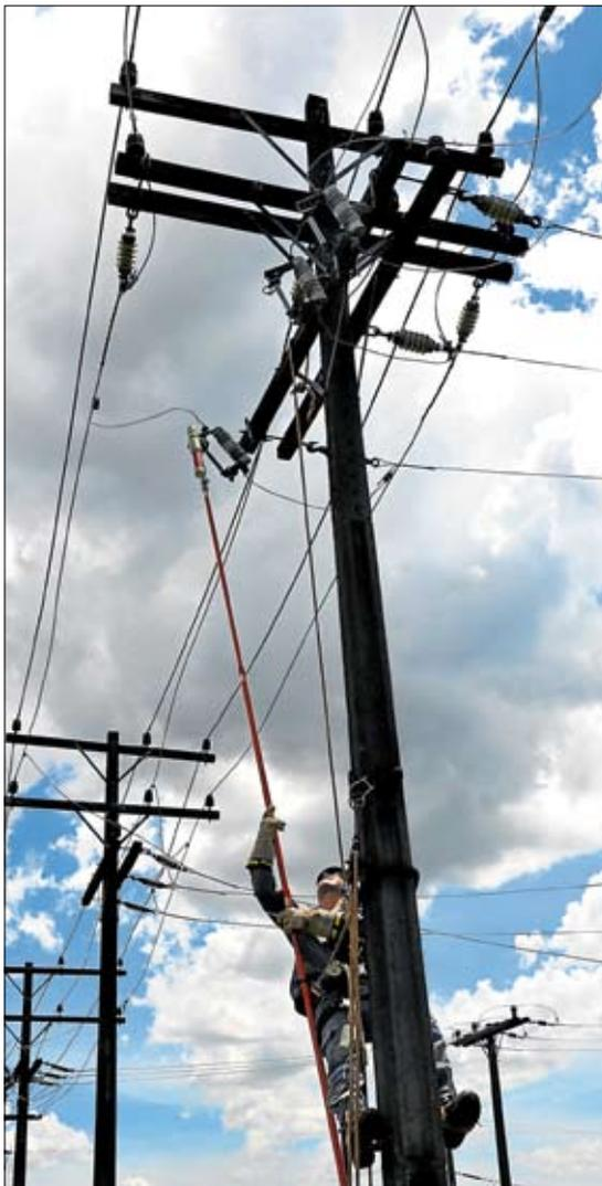
Abertura de chave fusível utilizando loadbuster da estrutura do poste
