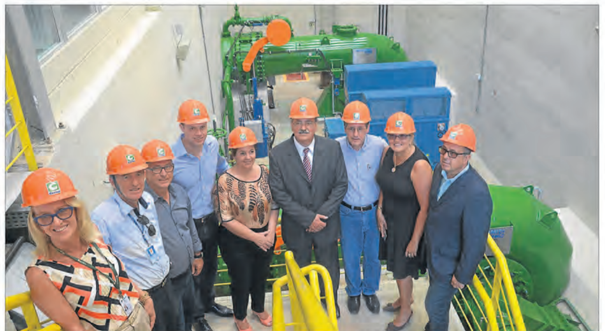
Lideranças conheceram a casa de força, onde é controlada a geração de energia elétrica
